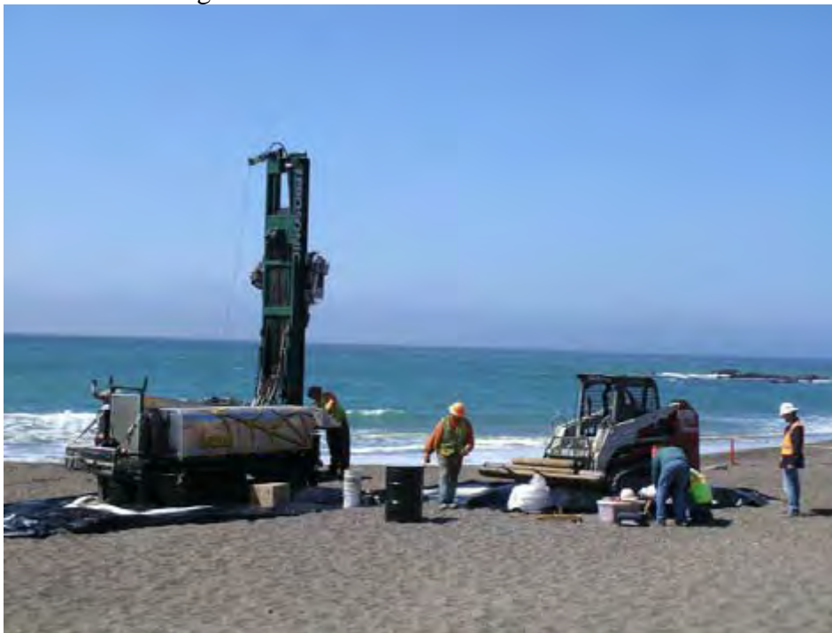
Rotosonic drill rig:
