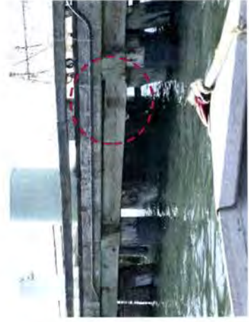
B. SAGGING BEAM AT WHARF N.T.S.
